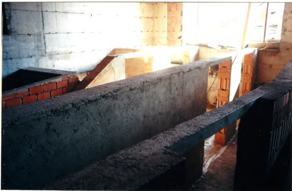
I RIPOSTIGLI SOTTO L'INGRESSO
