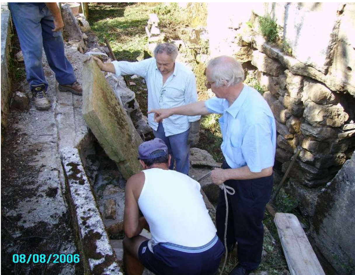
Volontari al lavoro. Don Angelo Cretti, studioso di medioevo, dirige i lavori di recupero ...
