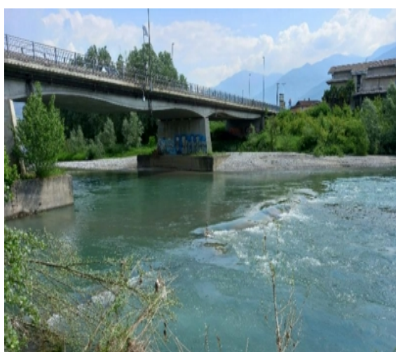
Il nuovo ponte
