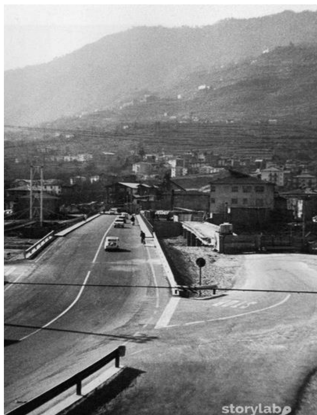
Foto storica che evidenzia il nuovo ponte; il vecchio ponte in fase di demolizione e la passerella provvisoria
