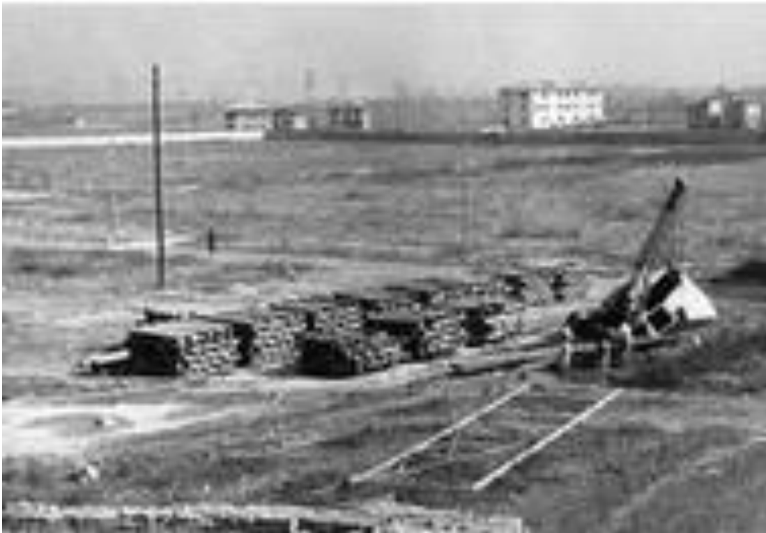
Foto storica 1954 – avvio lavori costruzione stabilimento Dalmine
