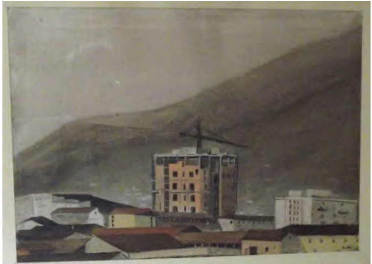
1962 - Dal tetto del seminario nuovo - Case in costruzione.
